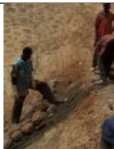
Pose des perrés
